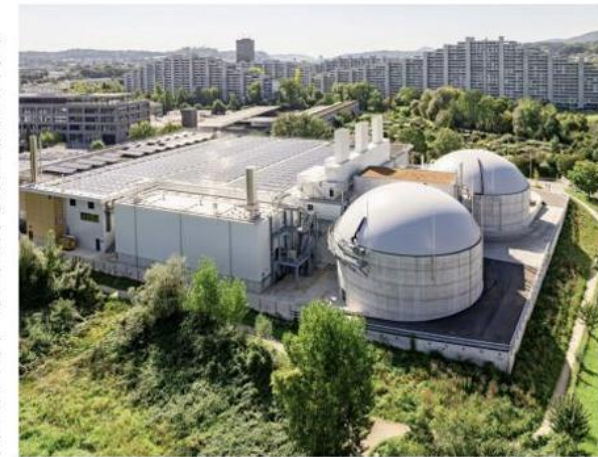
Die Biogasanlage von der Green Power AG sorgt mit ihren Emissionen für Ärger im Quartier. So etwa in den dahinter gelegenen Telli-Blöcken. Bild: Severin Bigler
